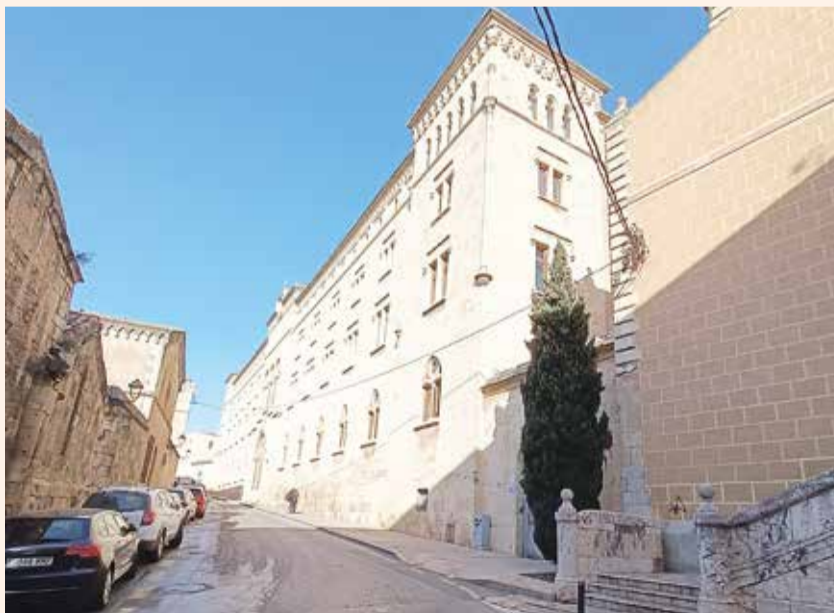
L'edifici de Seminari on, en pocs mesos, s'oferiran més de noranta places de residència per a la gent gran. / GRUP MIMARA
