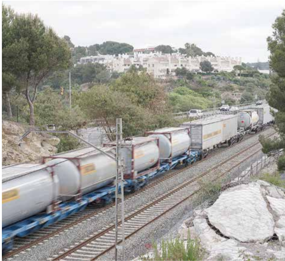
Un tren de mercaderies passant per la via que circula pels barris de Llevant de Tarragona. / JOAN CASAS
